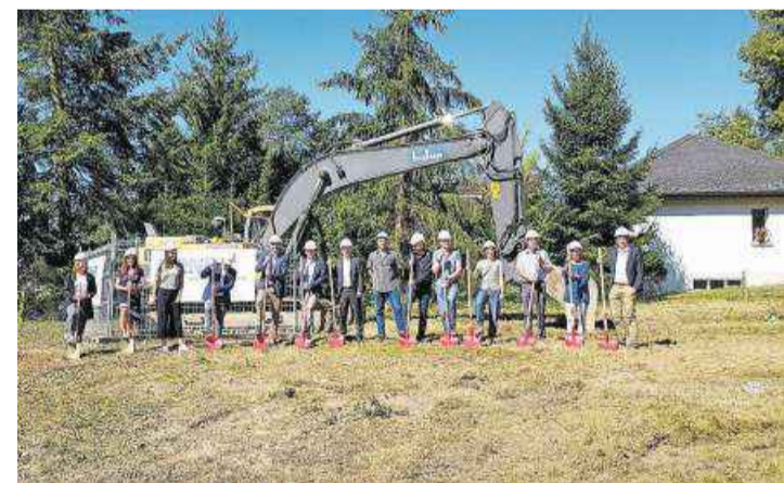
Spatenstich mit beteiligten Firmen und Nachbarn. Bild: Nadja Rohner
