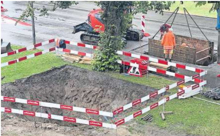
Diese Baugrube an der General-Guisan-Strasse sorgt für Irritation.
